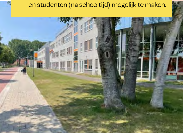
De buitenkant van het gebouw (foto: Annet Tuinstra)
