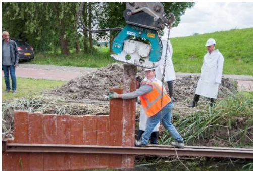
Voorbeelden van full-scale demonstrators: oeverbeschoeiing en geleidings-constructie.
